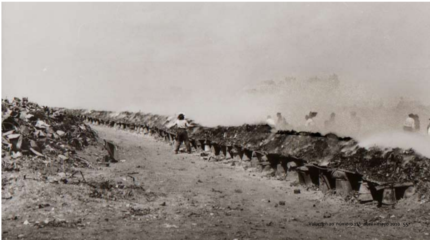
Disposición de residuos en hornallas a cielo abierto y su incineración en la Quema. Foto Municipalidad de Buenos Aires, ca. 1910, AGN
