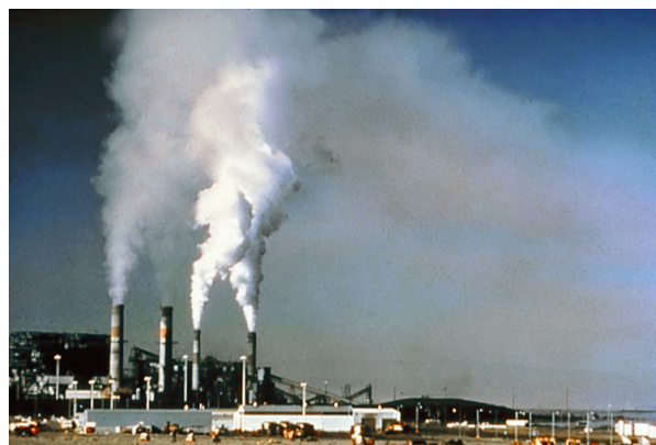
Esta planta generadora de Nuevo México libera dióxido de azufre y otros contaminantes del aire.
