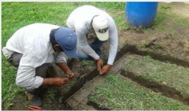
Construcción de la base del tanque (Feliciano y Martín)
